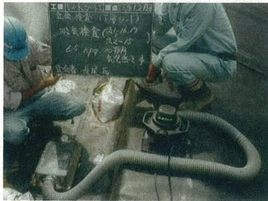
【負圧検査状況】
