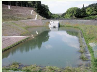
最下流部に設けており、50年に1回の大雨を想定して設計しています。
