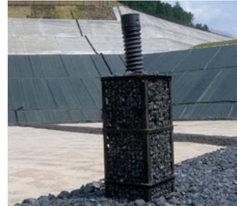
処分場内部のガス抜き管 ▶
