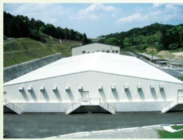
浸出水の水質を均質化し、浸出水量の変動に対して安定的に浸出水処理を行うため、貯留構造物下部に堤外浸出水貯留槽を設置しています。また、多降雨時に堤外浸出水貯留槽で賄いきれない量の浸出水が生じることに備え、埋立地内の最下流部に堤内浸出水貯留池を設けています。堤内浸出水貯留池への廃棄物の埋立は最終段階で行います。
