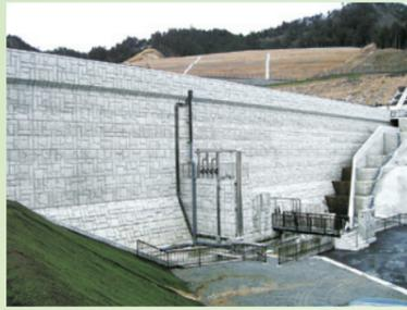
貯留構造物は、埋立廃棄物の流出や崩壊を防ぎ、埋め立てられた廃棄物を安全に貯留するために設けています。重力式ダム構造で、埋立進行状況や浸出水貯留水位、地震等の影響も考慮しており、埋立容量を貯留できる高さとしています。
