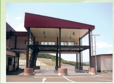
搬入車両の重量を入場時と退場時に計量します。この差を搬入された廃棄物量とします。(秤量40t,L=8.0m,H=3.8m,W=3.0m)
