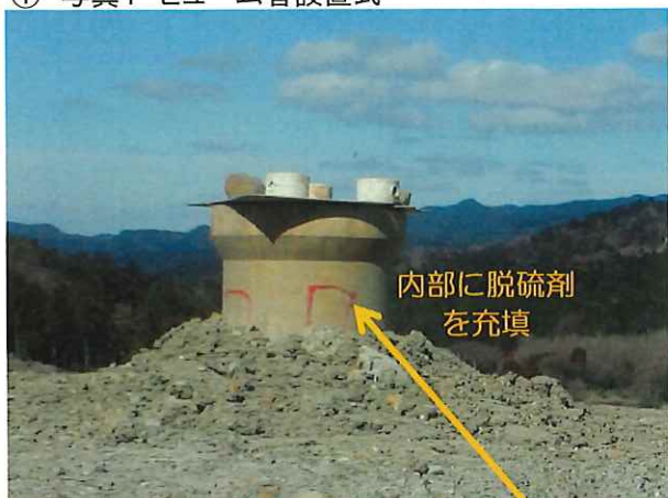
② 写真2 ポリエチレン管設置式
