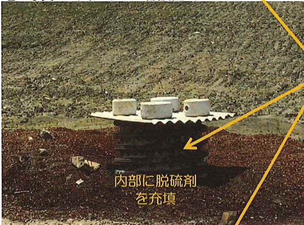
③ 写真3 ガス抜き管内部充填式
