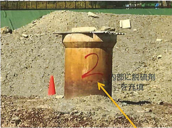
② 写真2 ポリエチレン管設置式
