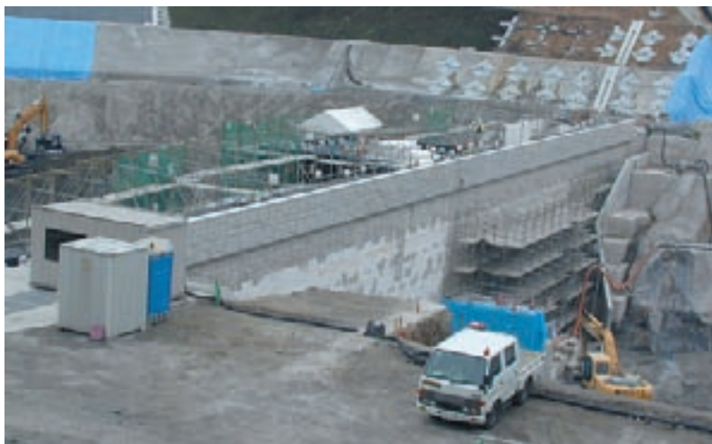
完成した貯留構造物
