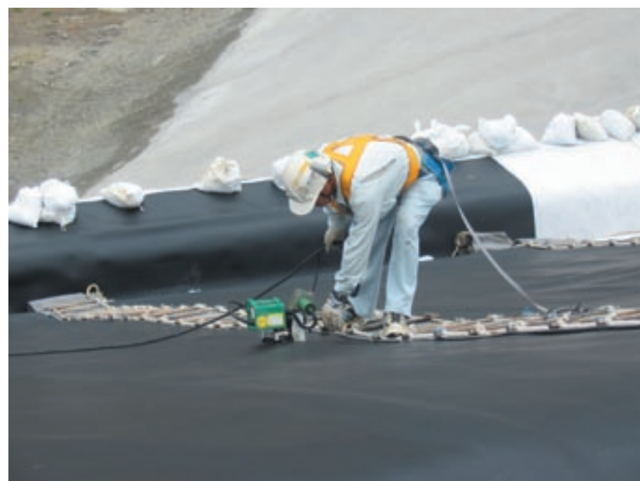
遮水シートの溶着工事
